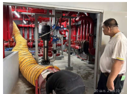
รูปที่ 51 พัดลมระบายอากาศภายในถังเก็บน้ำสำรอง
