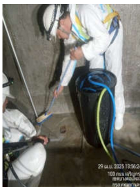
รูปที่ 50 เจ้าหน้าที่ทำความสะอาดถึงเก็บน้ำชั้นหลังคา
