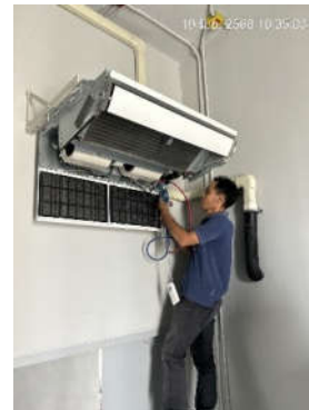
รูปที่ 53 เจ้าหน้าที่ทำความสะอาดเครื่องปรับอากาศ
